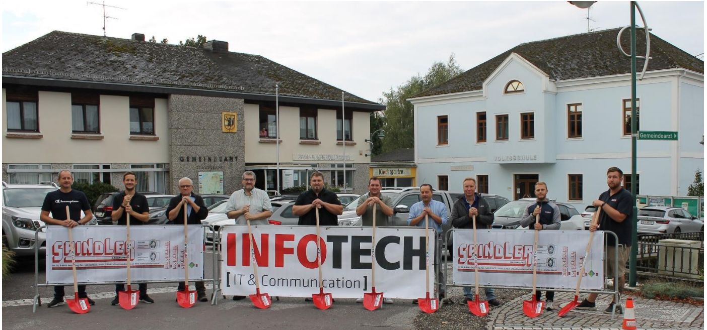
Spatenstichfoto Glasfaser-Projekt Weilbach mit Amtsleiter Peter Schneglberger, BGM Ludwig Huber und VBG M Alois Tischler mit Vertretern der Fa. Spindler (Bau) sowie Fa. Infotech (Netzbetrieb)
